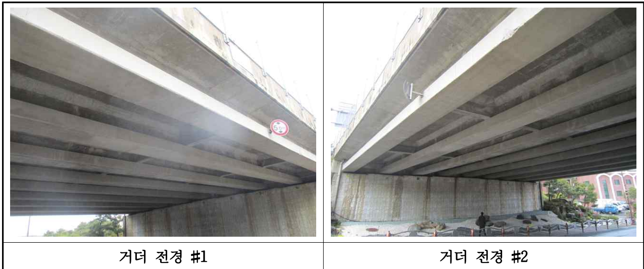
【사진 3.3】 거더 전경
