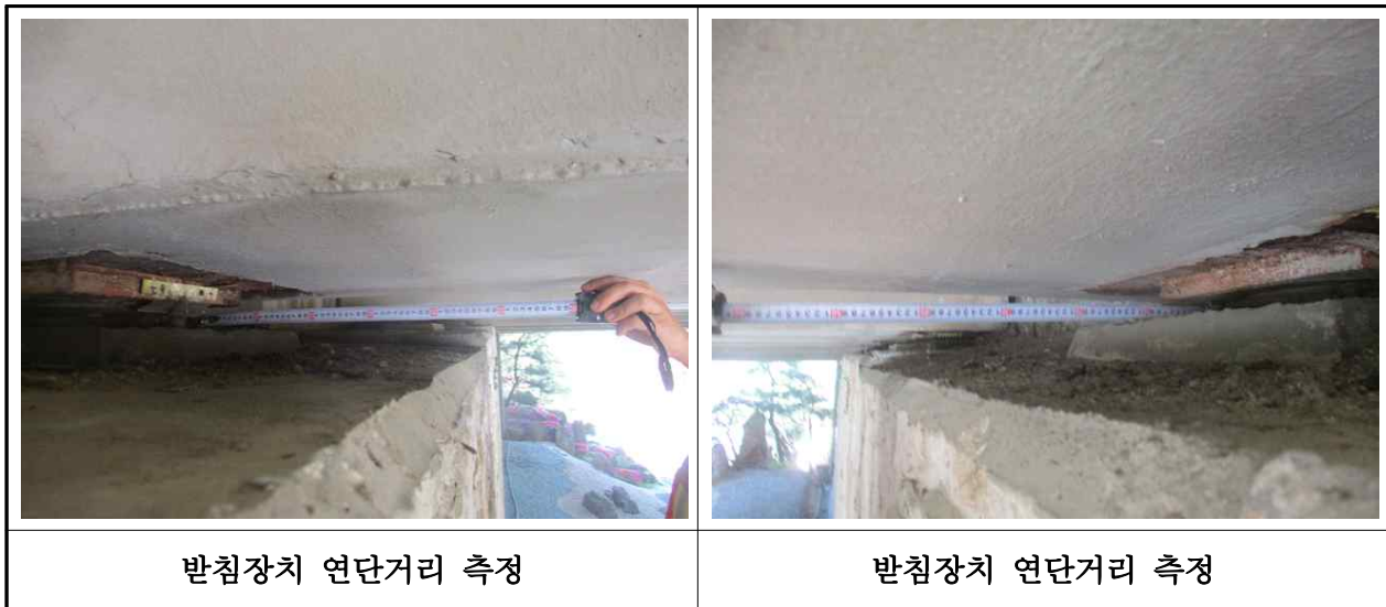
【사진 3.11】교량받침장치 연단거리측정
