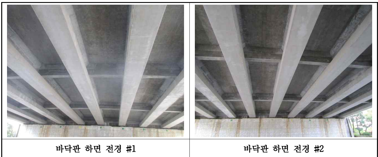
【사진 3.2】 바닥판하면 전경
