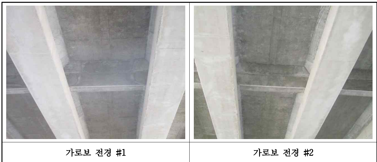
【사진 3.5】 가로보 전경
