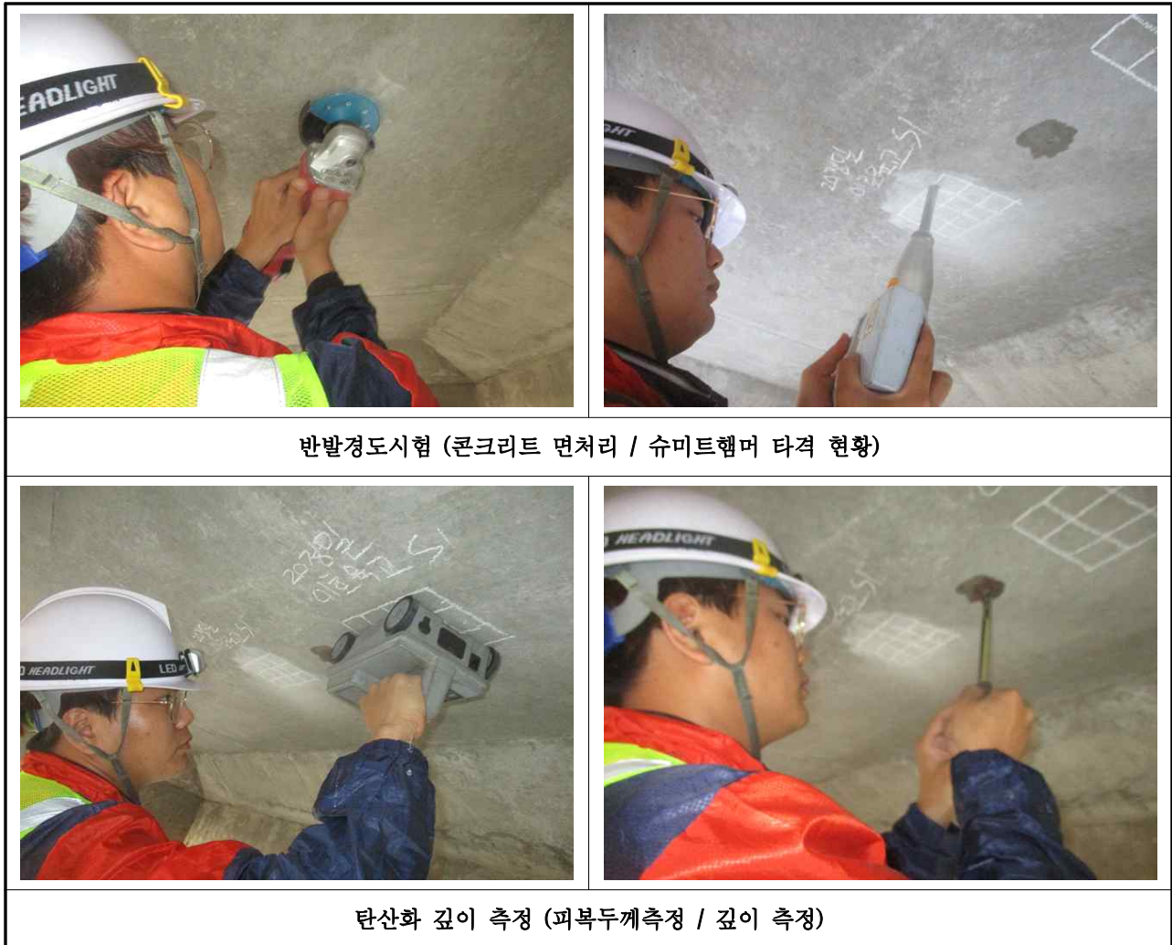
【사진 3.22】 콘크리트 내구성조사 현황
