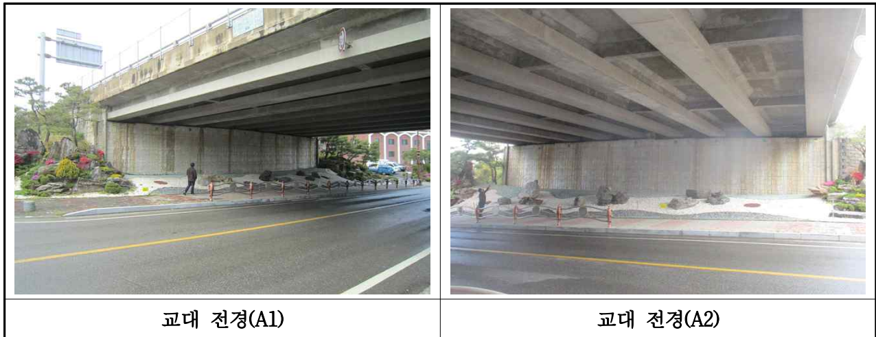
【사진 3.7】 교대 전경
